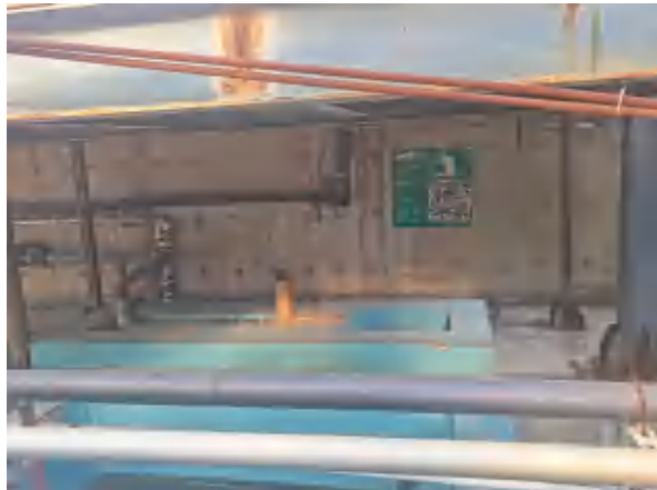
综合废水排放口
