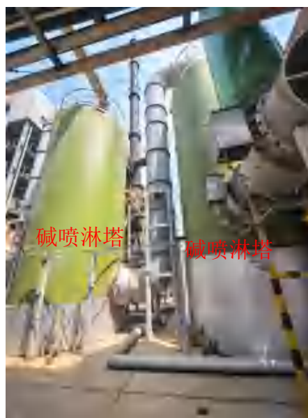
依托现有 DA001 的两级碱喷淋塔
