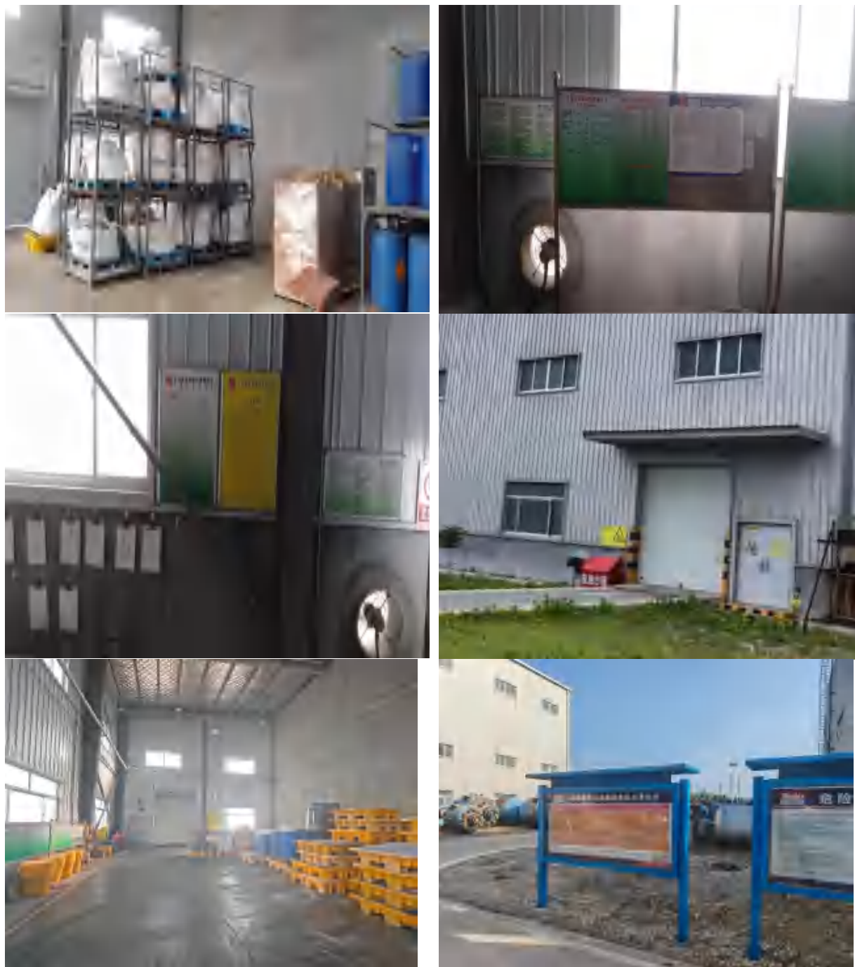
图 4-3 公司危废暂存间
