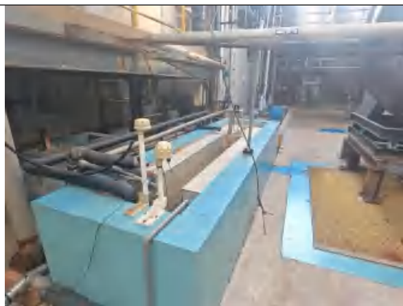
DW004 废水排放口
