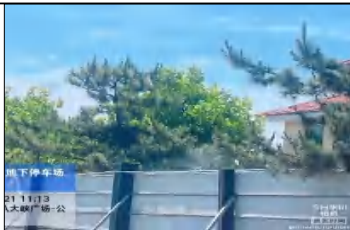
图 4-23 围墙喷淋系统
