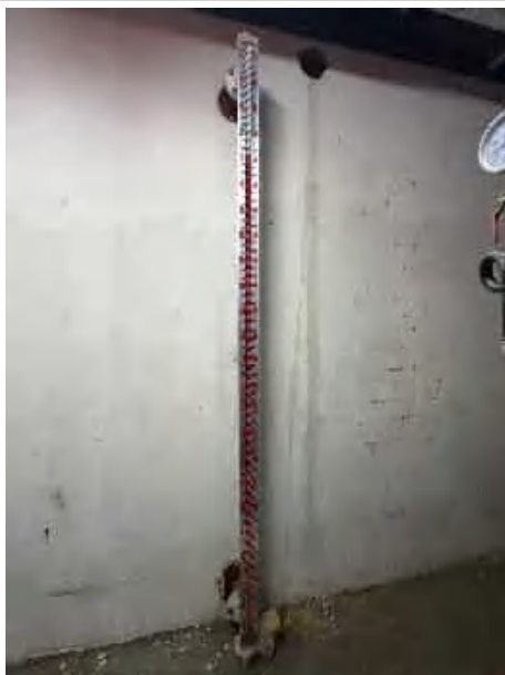
图 4-6 消防水池观测液位计及观测口
