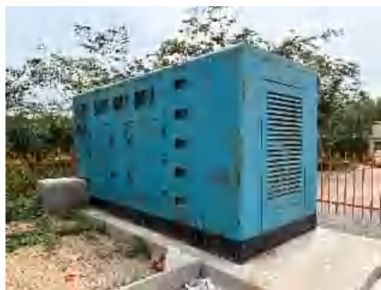
图 4-8 室外柴油发电机（应急备用）
