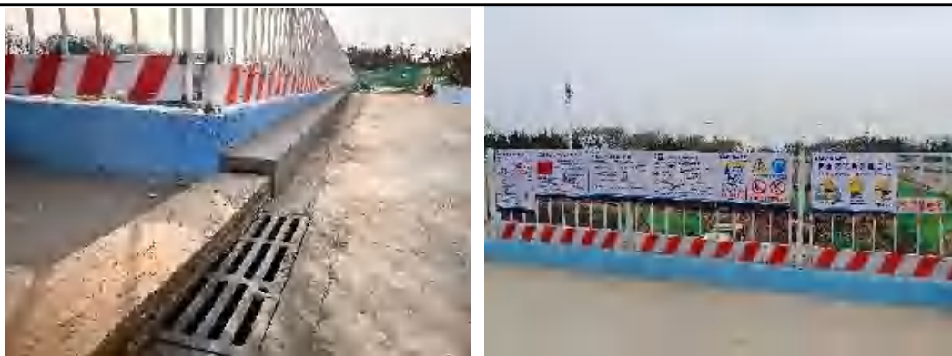
图 4-21 基坑挡水台
