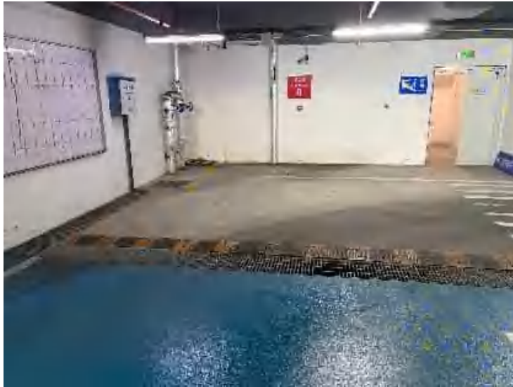
图 4-9 车库出入口排水沟
