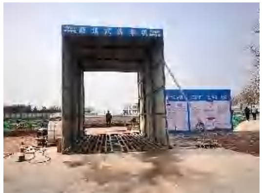
图 4-19 临时洗车槽
