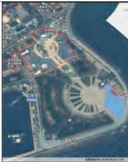
项目施工后景观图（2026 年 2 月）
