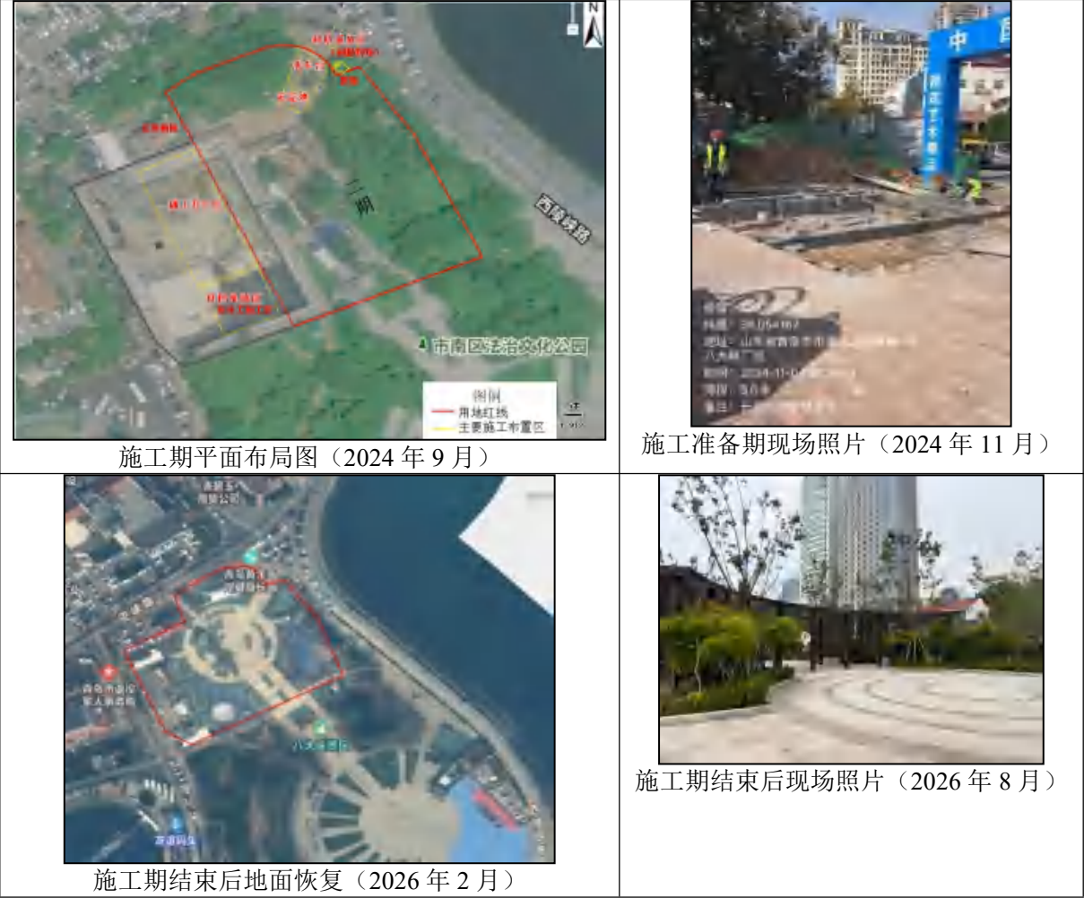
图 4-15 施工期及施工结束后现场对比图
