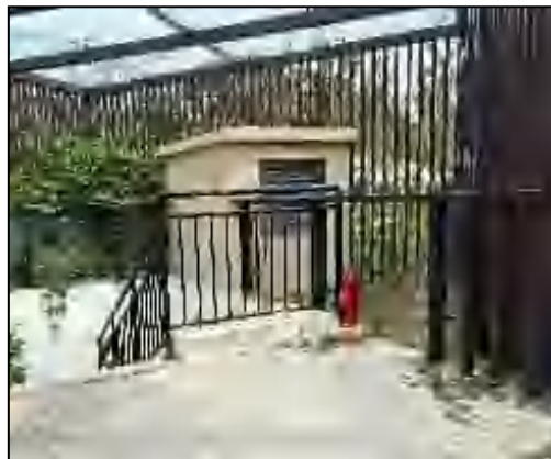
图 4-29 地下车库排风口
