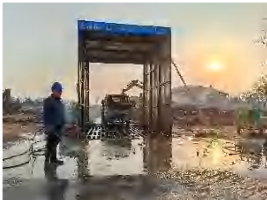
图 4-19 临时洗车槽
