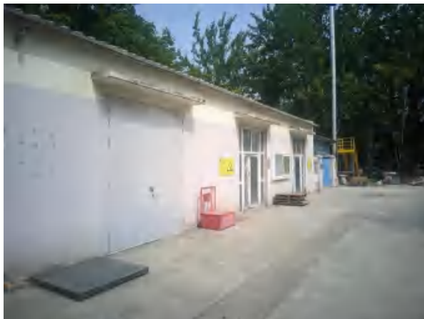
危废暂存间外部
