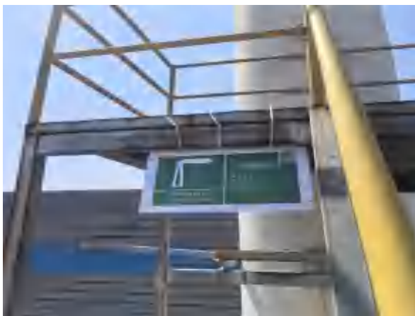
P3 排气筒标牌
