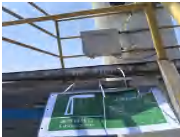
P4 排气筒标牌
