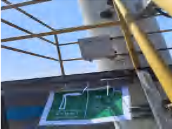
P5 排气筒标牌
