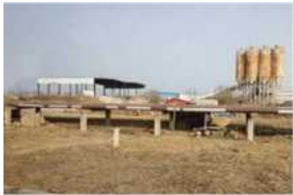
站址南混凝土厂房
