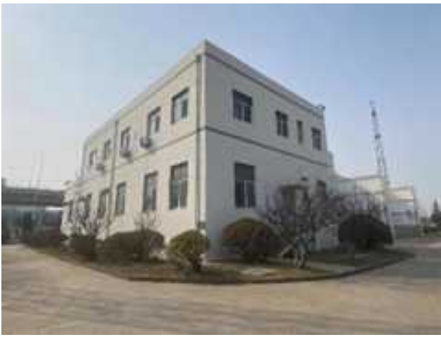
现有 110kV 炼化总变电站
