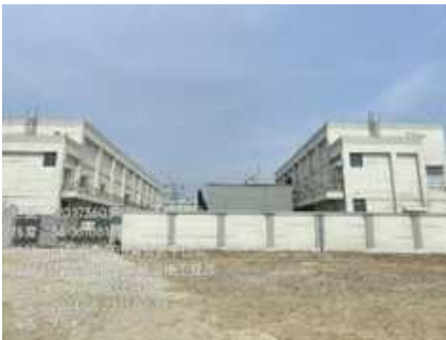
220kV 千石变电站
