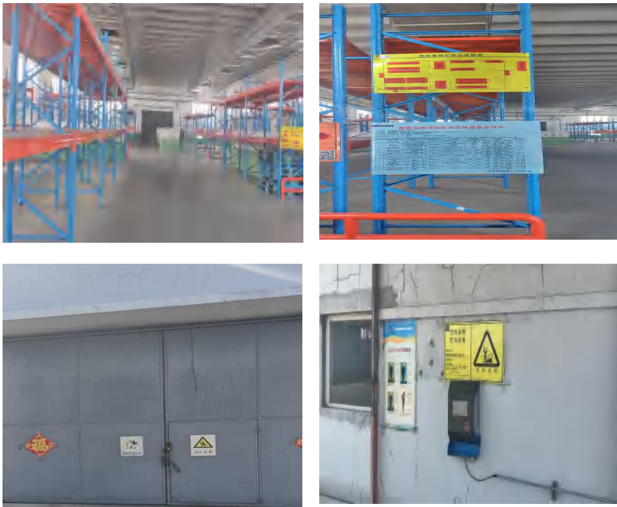
图 4-3 危险废物暂存库
